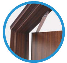
Дверной доводчик скрытого монтажа – стандартная комплектация противопожарной двери
